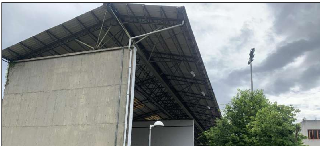
Fotografía n°7.- Cubierta de fibrocemento de los frontones.
