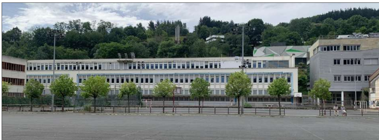
Fotografía nº4.- Vista hacia la C/Loramendi.
