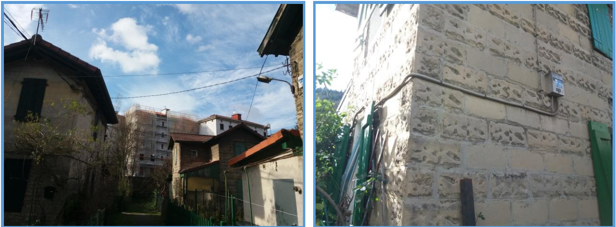
Ilustración 4. Cableados e instalaciones
