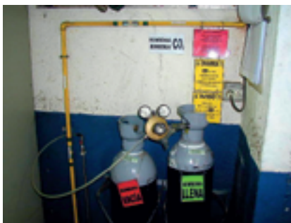
Tratamientos Térmicos – Señalar anomalías. Carteles que señalan el estado de las botellas.
