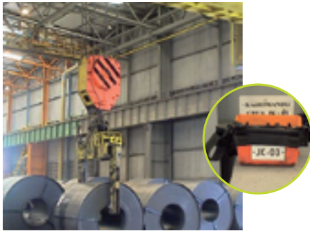
Arcelor Mittal Sestao Señalar anomalías. Cada mano se pinta del color de su grúa para evitar errores
