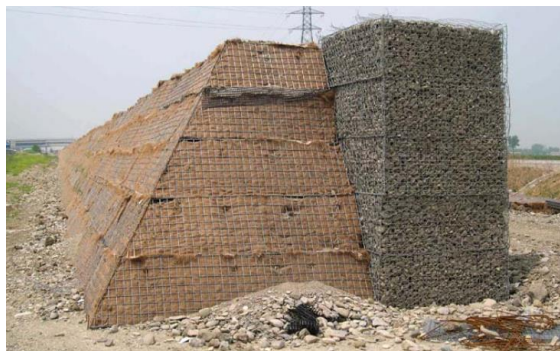
Fotografía de pantalla conformada por materiales pétreos + relleno estructural
